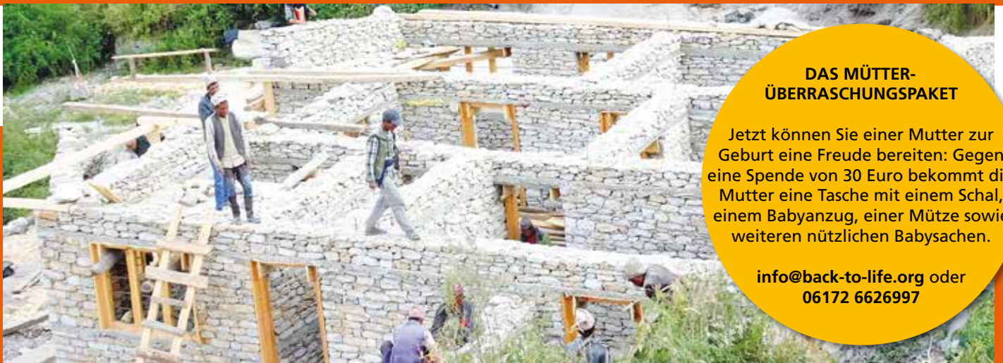
Rowa: Nicht mehr lange und das Dach kann montiert werden
