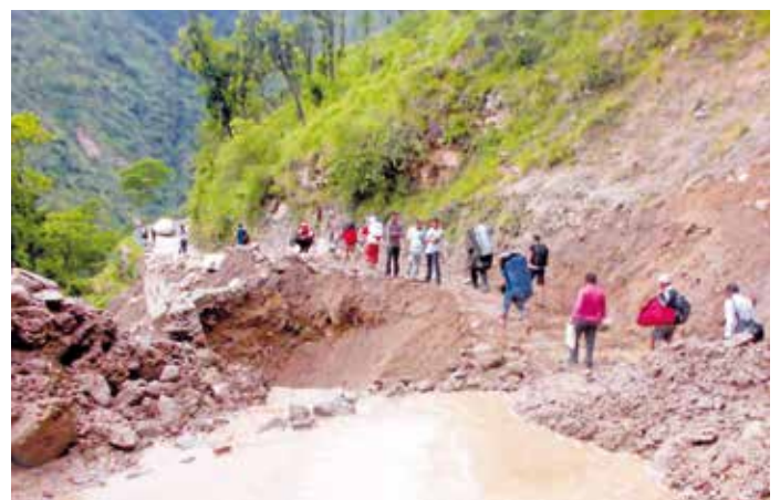
Unterspülte Straße. Ab hier nur noch zu Fuß
